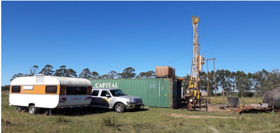
Figura 3: Execução do poço CBM-002-ST-RS na cidade de Osório/RS em 2018/2019.
