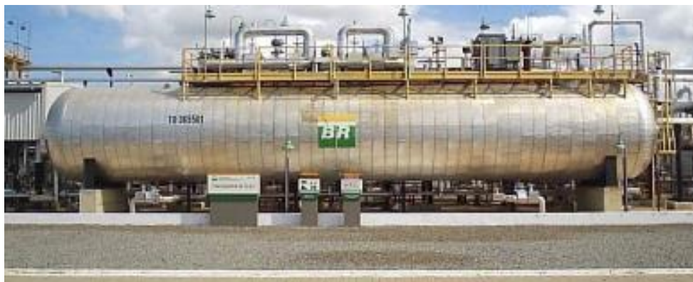
Figura 1: Vaso separador trifásico horizontal.
