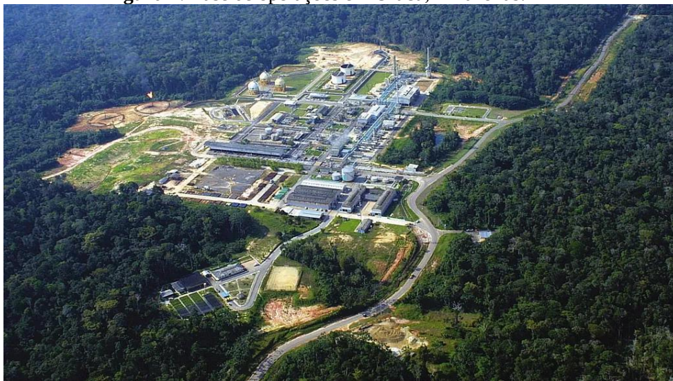
Figura 1. Base de operações em Urucu, Amazonas.
