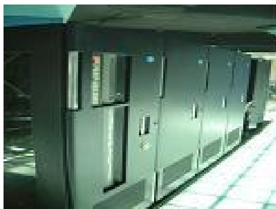
Figura 3. Instalações Petrobank® Reino Unido
