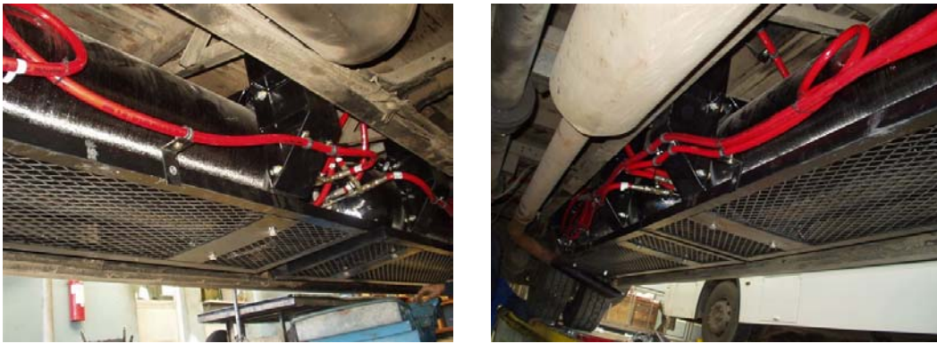
Figura 9. Vista geral da montagem com grades de proteção incorporada a estrutura de fixação.
