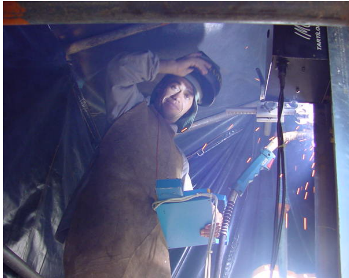
Figura 3: Foto do soldador/operador utilizando o Tartilope V2F na soldagem do silo.
