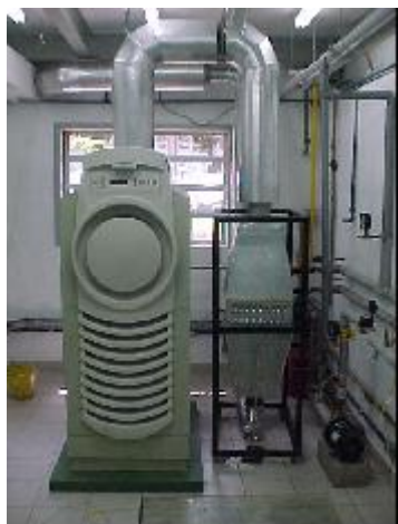
Figura 2- Foto da micro-turbina e trocador de calor para água quente
