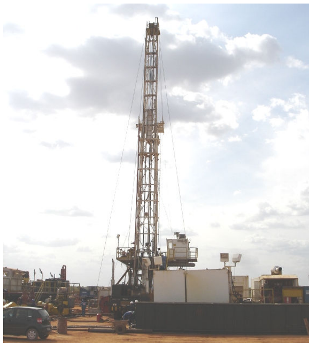
Figura 1. Perfuração do poço 1-POTI-4-RN
