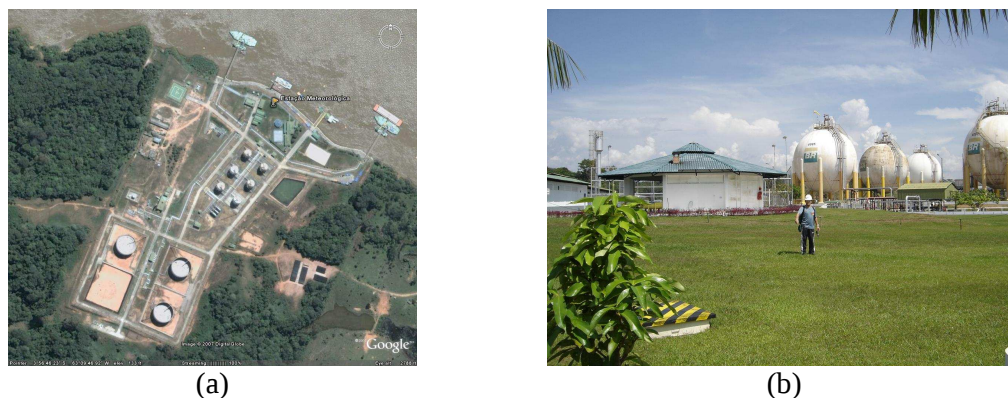
Figura 2. a) Vista aérea do Terminal do Solimões (TESOL) (a bandeirinha amarela mostra o ponto onde será instalada a estação meteorológica do projeto PIATAM) e b) foto do local selecionado para a instalação da mesma.
