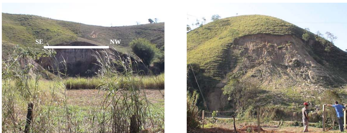
Figura 2: A esquerda observamos um deslizamento planar com alto ângulo de inclinação e direção SE-NW. Na foto da direita vemos um escorregamento de pequeno porte com amplitude próxima dos 12 m.
