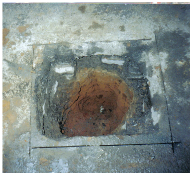
Figura 1. Abertura de vala no MND. Fonte: MASSARA, 2005.
