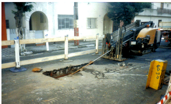
Figura 3. Perfuratriz rotativa e abertura do furo piloto. Fonte: MASSARA, 2005.
