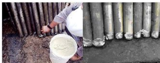
Figura 1 – Aplicação das graxas em tubos de perfuração de poços.
