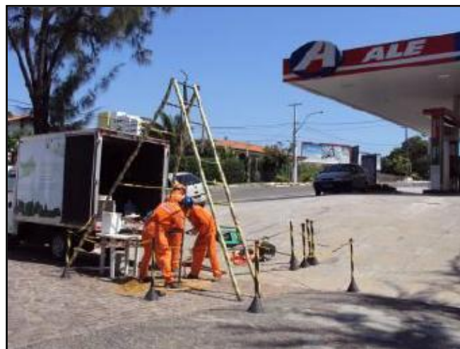
Figura 3 – Sondagem a trado sendo efetuada
