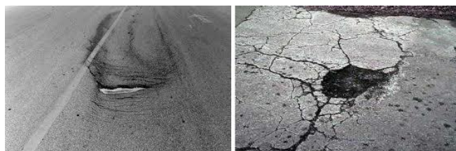
Figura 1: Exemplo de formação de (a) trilha de roda e (b) panela (Lutif, 2011)
