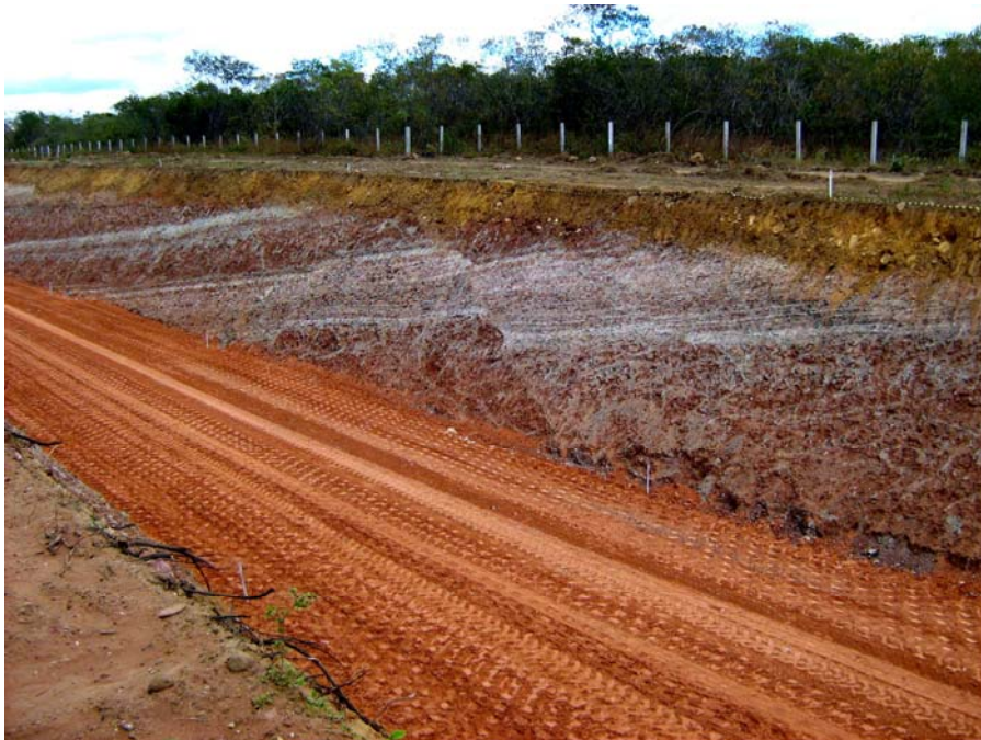
Figura 3 – Conjunto de falhas normais escalonadas com rotação dos blocos e formação de antiforme de volteio (estrutura roll-over ) que afetaram folhelhos e arenitos finos da Formação Brejo Santo. Talude com aproximadamente 20 m de altura. Corte da Ferrovia Transnordestina (em construção).
