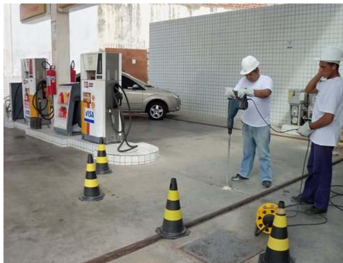
Figura 01 – Perfuração para avaliação dos gases do solo (malha de VOC).
