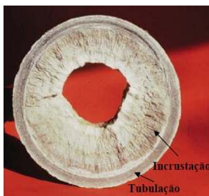
Figura 02: Incrustação a \text{CaCO}_3 em uma tubulação de 3 polegadas.
