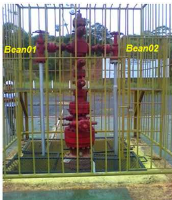
Figura 1 – Árvore de natal do poço 01-FMO-001-BA: Bean01 à esquerda; Bean02 à direita (Nascimento, 2011)
