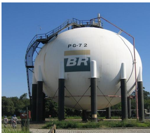
Figura 1 - Exemplo de tanque de armazenamento
